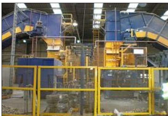
↓ 【プレス機は2台設置】
